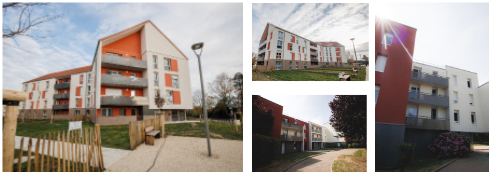
Réalisations de SEMINOR à Fécamp (76)
