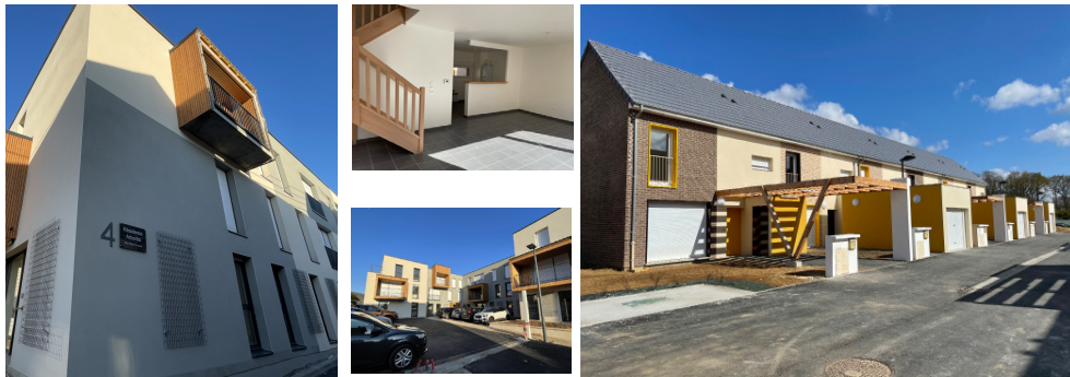
Réalisation de Logéal Immobilière à Darnétal (76)
